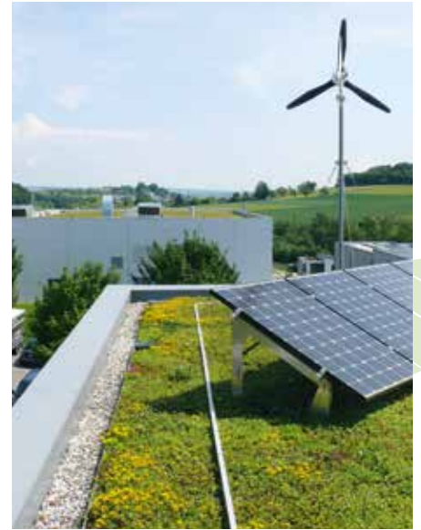
Le domaine d'utilisation classique du système de rail Fallnet® : les zones en bordure sur lesquelles il faut souvent intervenir. Une fois arrimé au suiveur, l'opérateur peut agir en totale sécurité.
