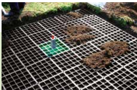
Lors de la mise en œuvre, il est absolument nécessaire de contrôler si le lestage requis est atteint.
