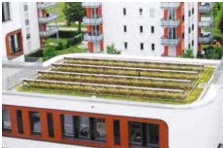
Afin d'exploiter du mieux possible la surface en toiture, les installations solaires sont fréquemment implantées jusqu'à très près du bord du toit.
