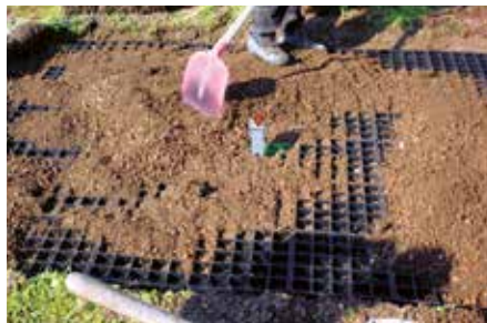
Le substrat pénètre parfaitement bien dans les évidements alvéolés des éléments grillagés du Fallnet® SR.
