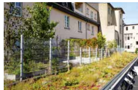
Après la pose de Fallnet® SB 200-Rail, le bord de la toiture est ainsi sécurisé pour la poursuite des travaux.
