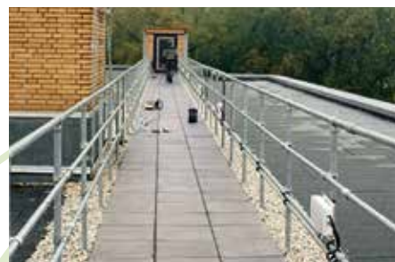
Le logement de poteau de la base de balustrade GB est muni en fonction de l'objet d'une deuxième bride vissée de fixation pour la pose d'une balustrade de part et d'autre d'une issue de secours.
