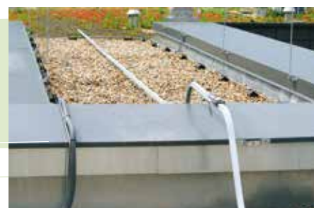
L'élément de rail en col de cygne permet de surmonter élégamment un décalage en hauteur puisque le suiveur peut continuer à coulisser sans interruption.
