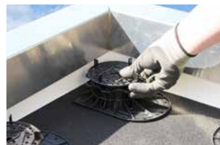
Éléments de surélévation Elefeet® A 12, A 22 et A 67, combinables de multiples façons en continu jusqu'à une hauteur d'env. 500 mm
