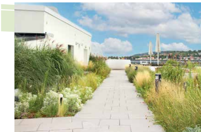
Végétalisation intensive de toiture
