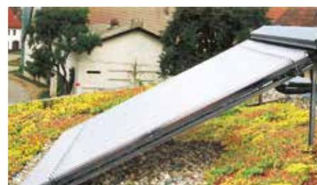
Sur les toitures en faible pente, la végétalisation est compatible avec la production d'énergie solaire. Il convient de déterminer au cas par cas le mode de fixation sur le toit des installations avec la ZinCo Base solaire pour que l'ensemble soit stable.
