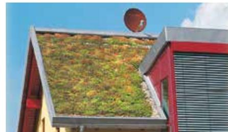
Sur ce toit à pente d'env. 30°, une traverse anti-poussée supplémentaire sur la surface du toit a été prévue en plus du bord de rive stable.
