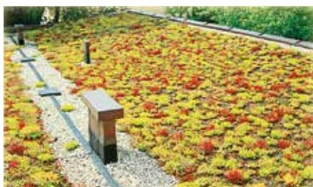
Cette toiture, d'une pente d'environ 5°, drainée par un caniveau, ne nécessite pas de mesures particulières.
