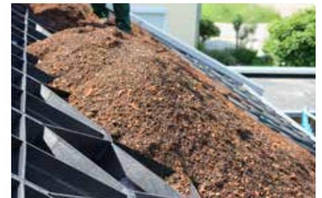
Les éléments Georaster® sont ensuite remplis et recouverts sur 1 cm de substrat de système « Lavandulis-léger ». Ce substrat peut être soufflé sur le toit à partir d'un camion-silo.
