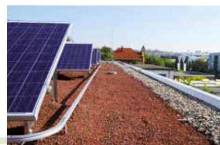
Montage sans perçage du toit puisque le lest requis peut être réalisé avec du Zincolit®, du substrat de système ou une autre matière en vrac appropriée.
