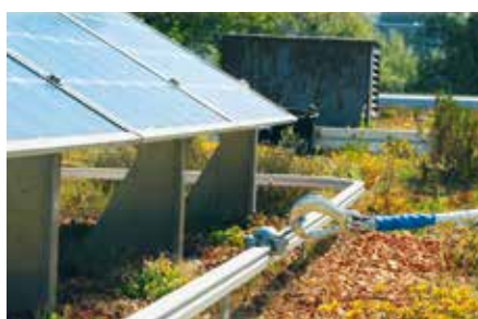
Le suiveur horizontal mobile pour l'équipement de protection individuelle est un gage d'ergonomie maximal puisque l'utilisateur n'a besoin de s'y arrimer qu'une seule et unique fois pour ensuite pouvoir se déplacer librement en longeant le rail.
