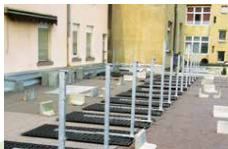
Après la pose d'une couche de protection sur l'étanchéité, mise en place des bases de balustrade GB/GB angle et montage des poteaux et des supports pour le rail d'ancrage.
