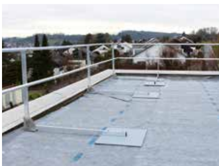
L'illustration montre les modules de poteaux avant la pose de la structure du système de végétalisation.
