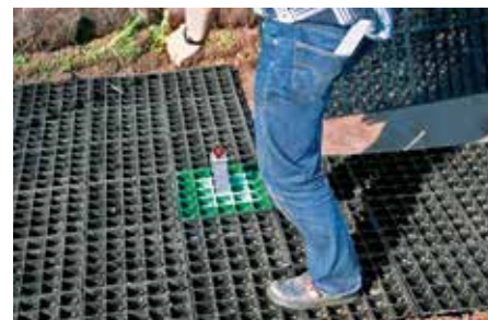
Au total, on arrive à quatre éléments pré-emboîtés qui forment un disque d'env. 5,3 m² répartissant les forces.
