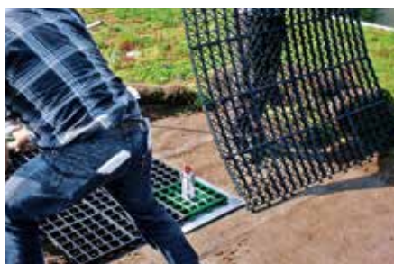
Placés de la sorte au centre, les autres éléments sont reliés à l'élément grillagé initial.
