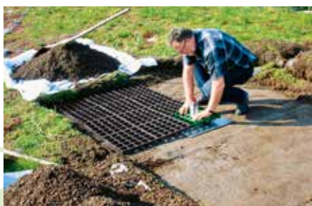
Fallnet® SR peut être mis en œuvre ultérieurement sur une végétalisation existante. Pose du point d'ancrage dans l'élément grillagé.
