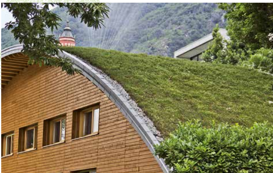
Les toits en pente exigent des mesures particulières pour sécuriser la végétation.
